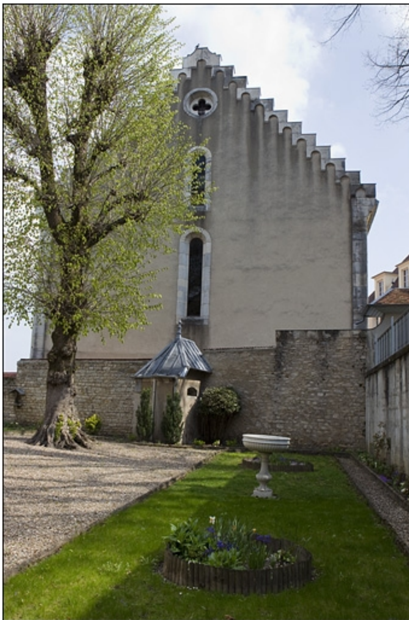
Vue éloignée du pavillon de jardin.
