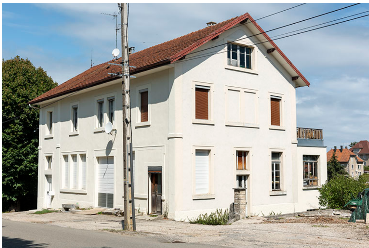
Façades antérieure et latérale droite.
