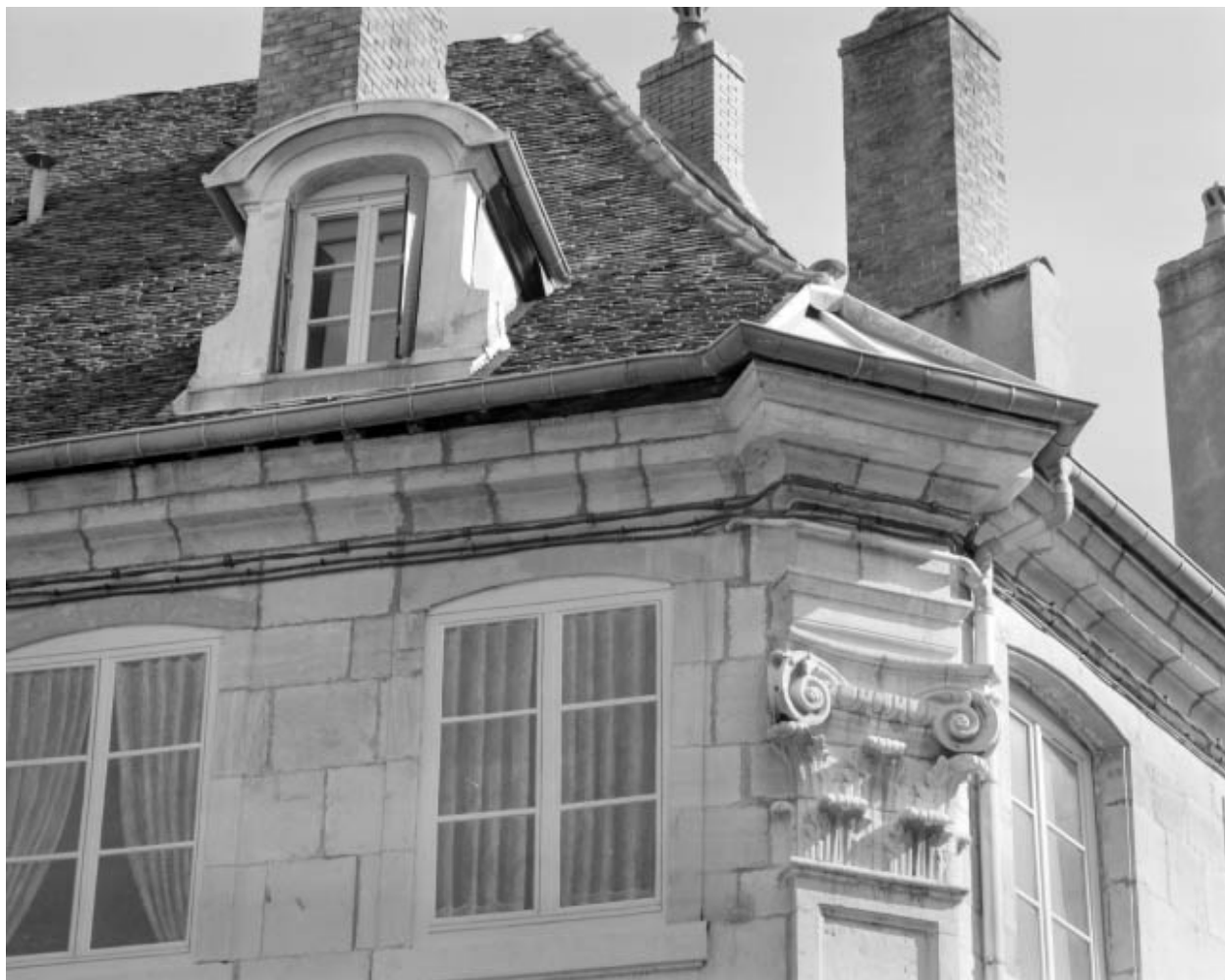
Détail du chapiteau du pilastre d'angle.
