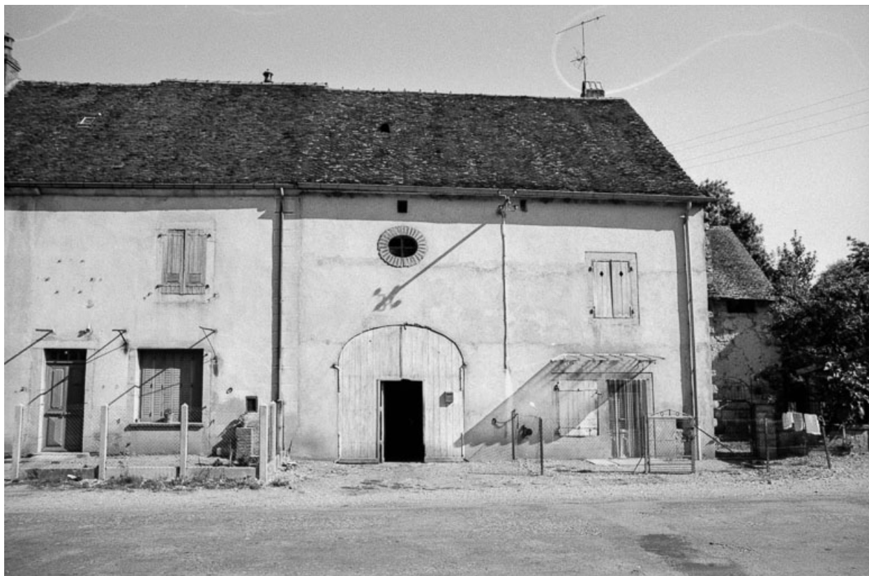
Ferme : façade antérieure.
