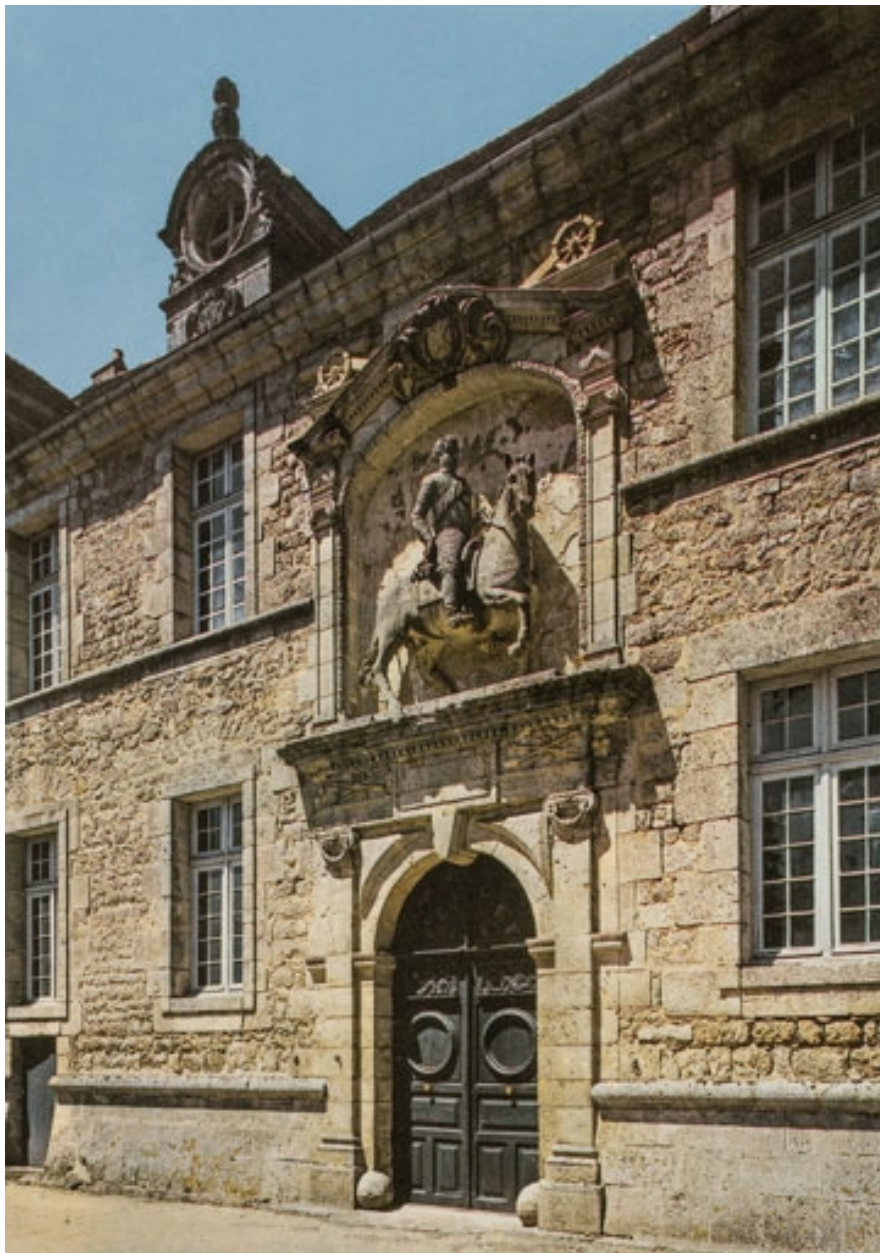
Façade sud-est, travée centrale, avant restauration.
