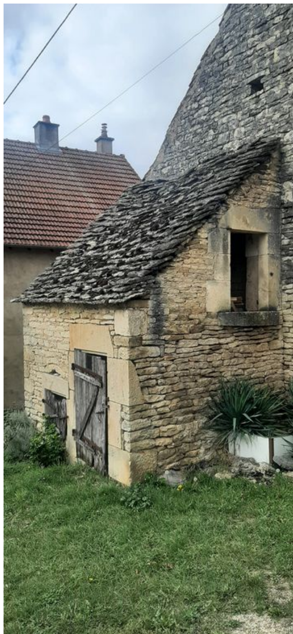
Vue du mur pignon et de la rive du toit en laves.
