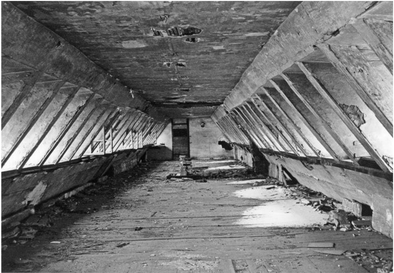
Usine Japy, à Badevel, en 1978 : intérieur du deuxième étage de comble de l'atelier d'horlogerie.
