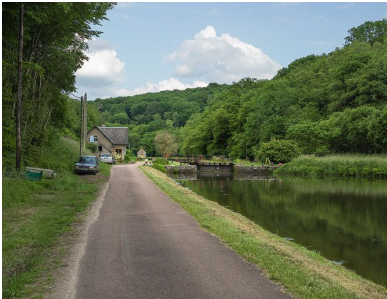
Le site d'écluse vu d'amont.
