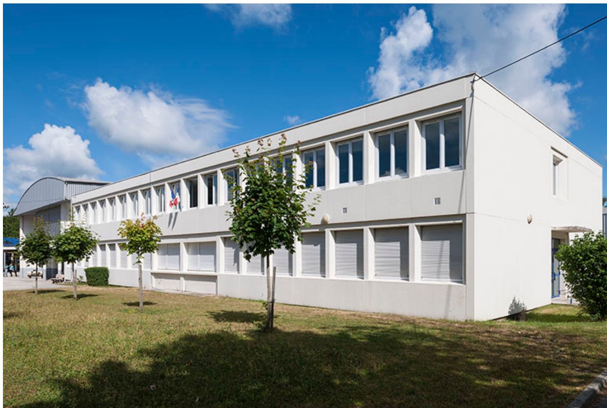
Ateliers, façade latérale Sud.
