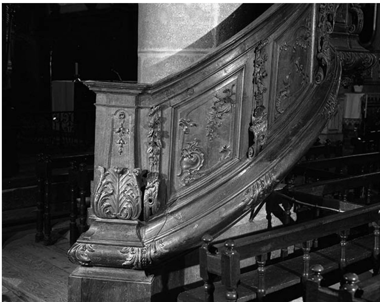
Le départ de la rampe.
