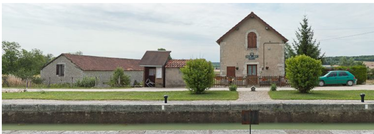
Vue d'ensemble du site d'écluse.
