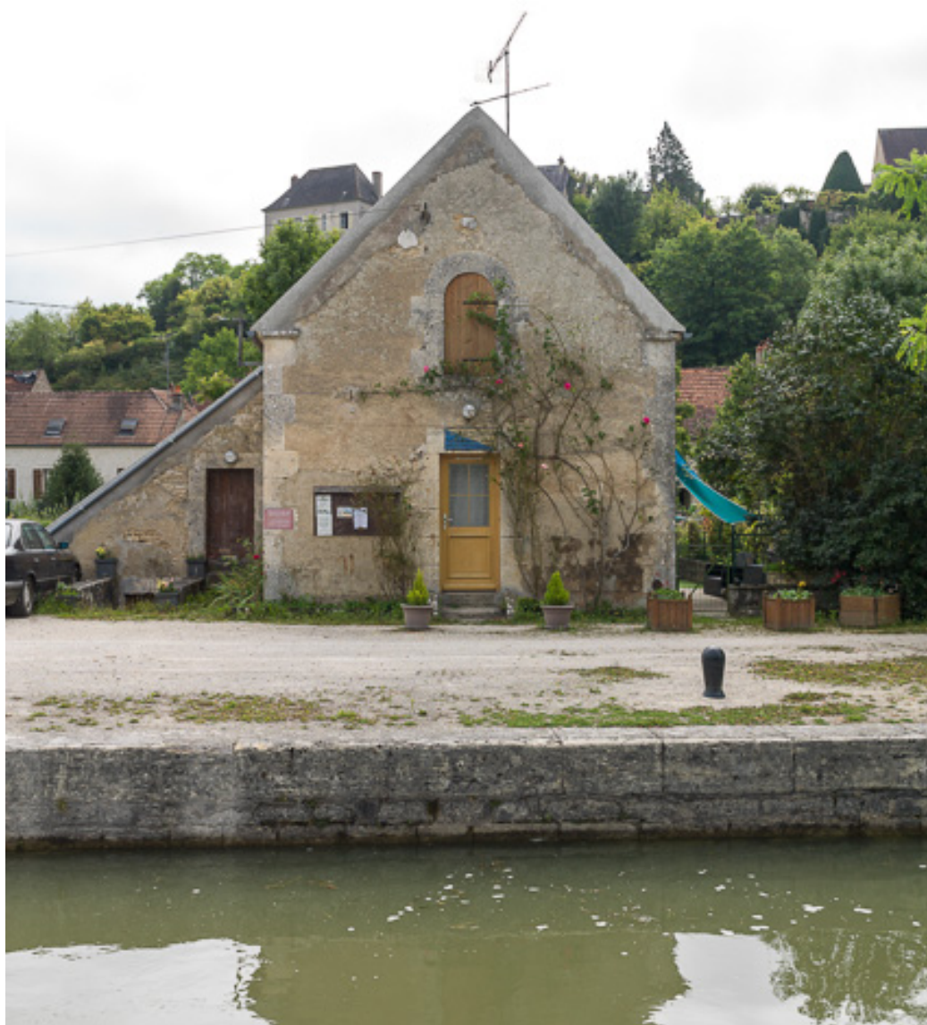
Mur pignon de la maison éclésièrre
