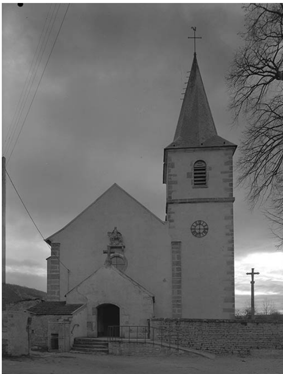
Façade occidentale avec porche et clocher.
