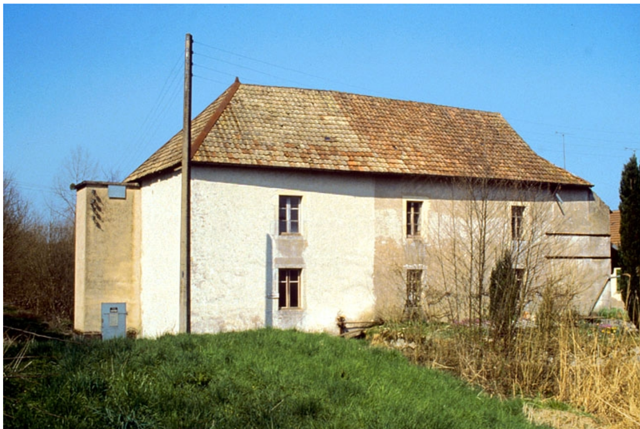
Façade latérale gauche, depuis le sud.
