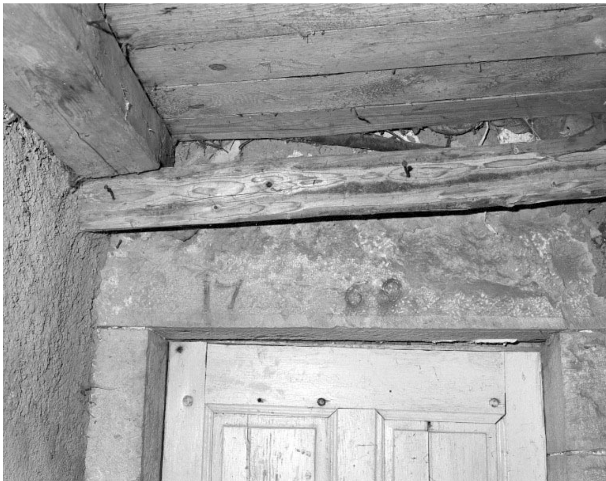
Porte d'accès au logis.
