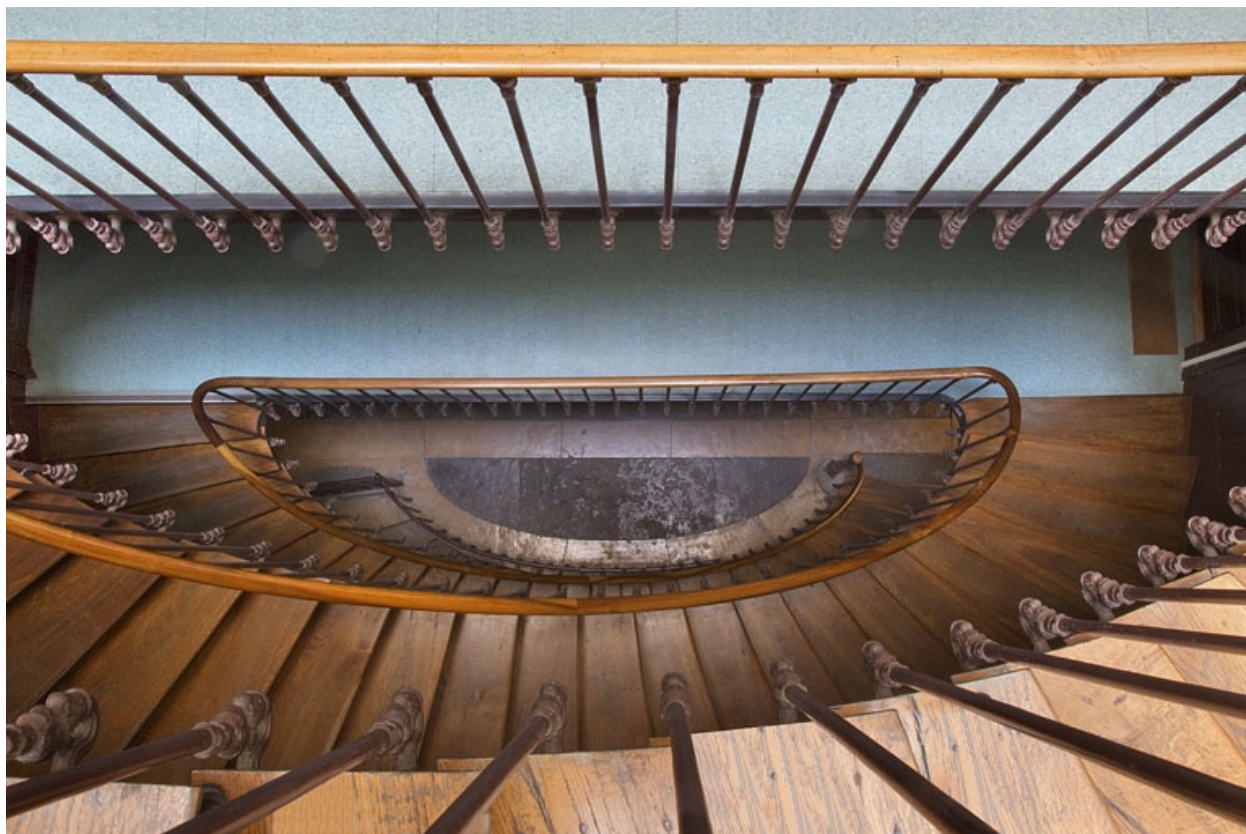
Intérieur, escalier : vue plongeante.
