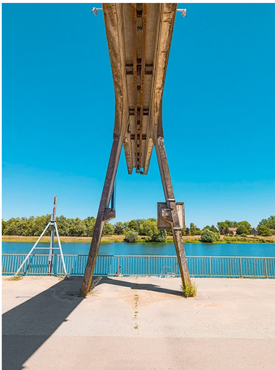
Portique de déchargement avec poulie.
