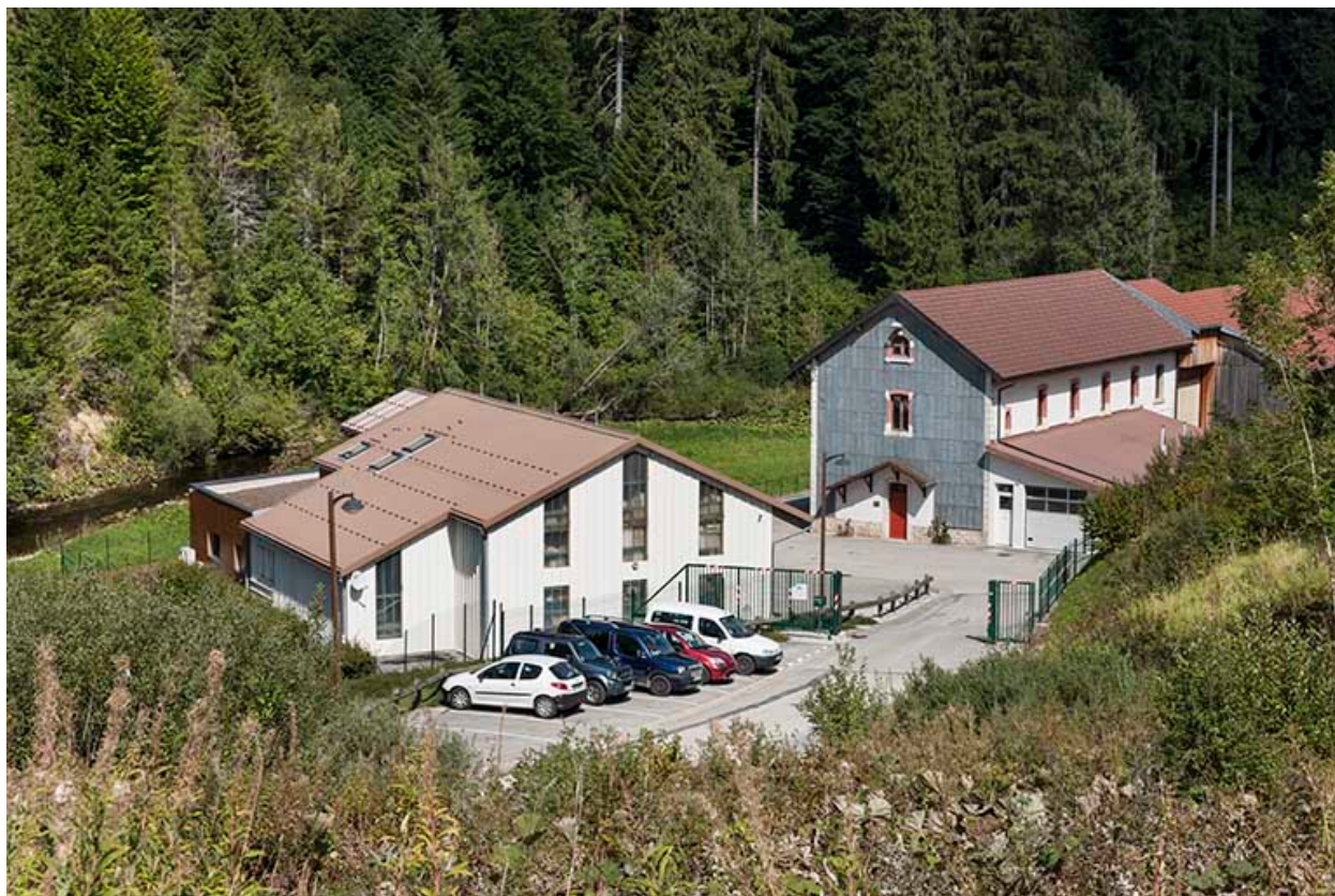
Vue rapprochée depuis le sud-ouest.
