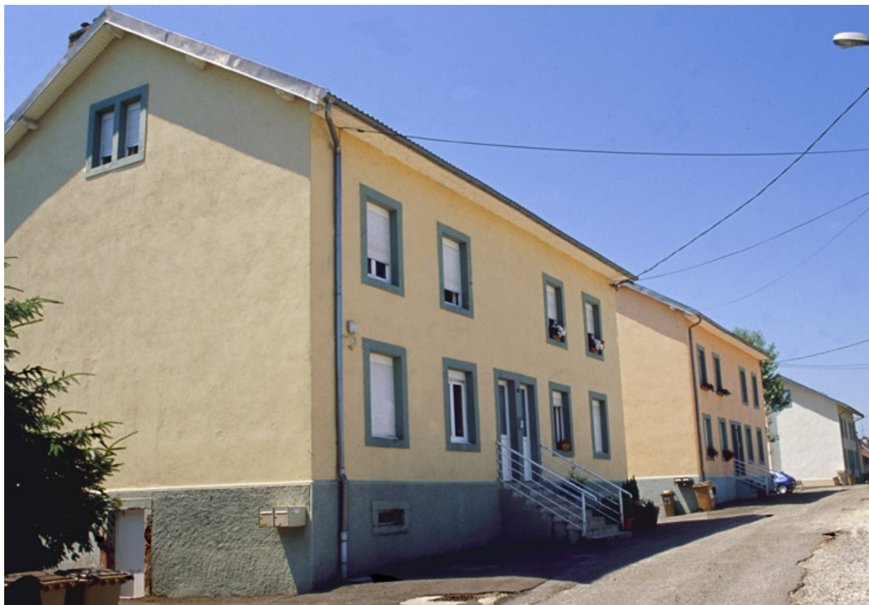
Logements ouvriers rue de la Libération.
