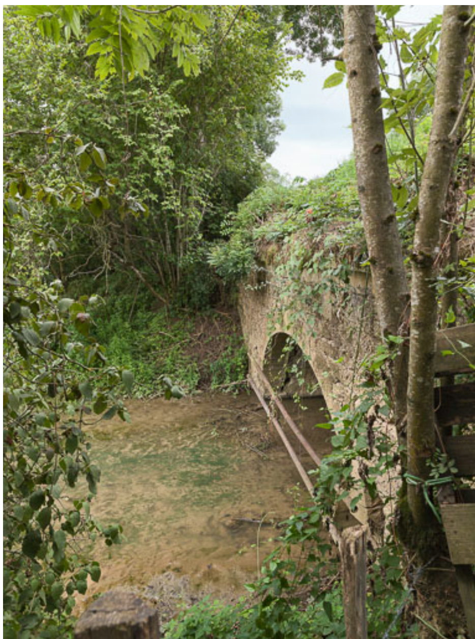
Vue de l'aqueduc.
