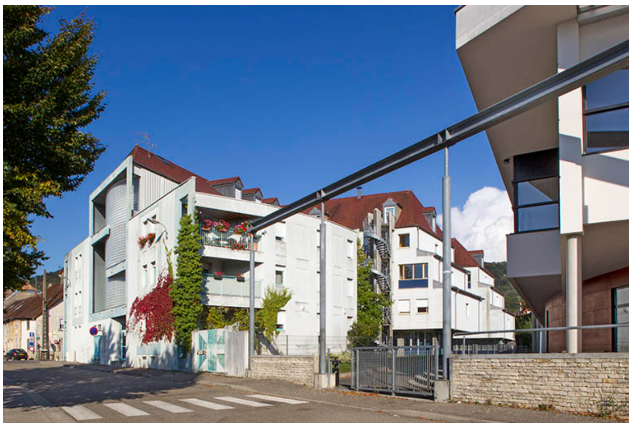
Internat : entrée, rue de Versailles.
