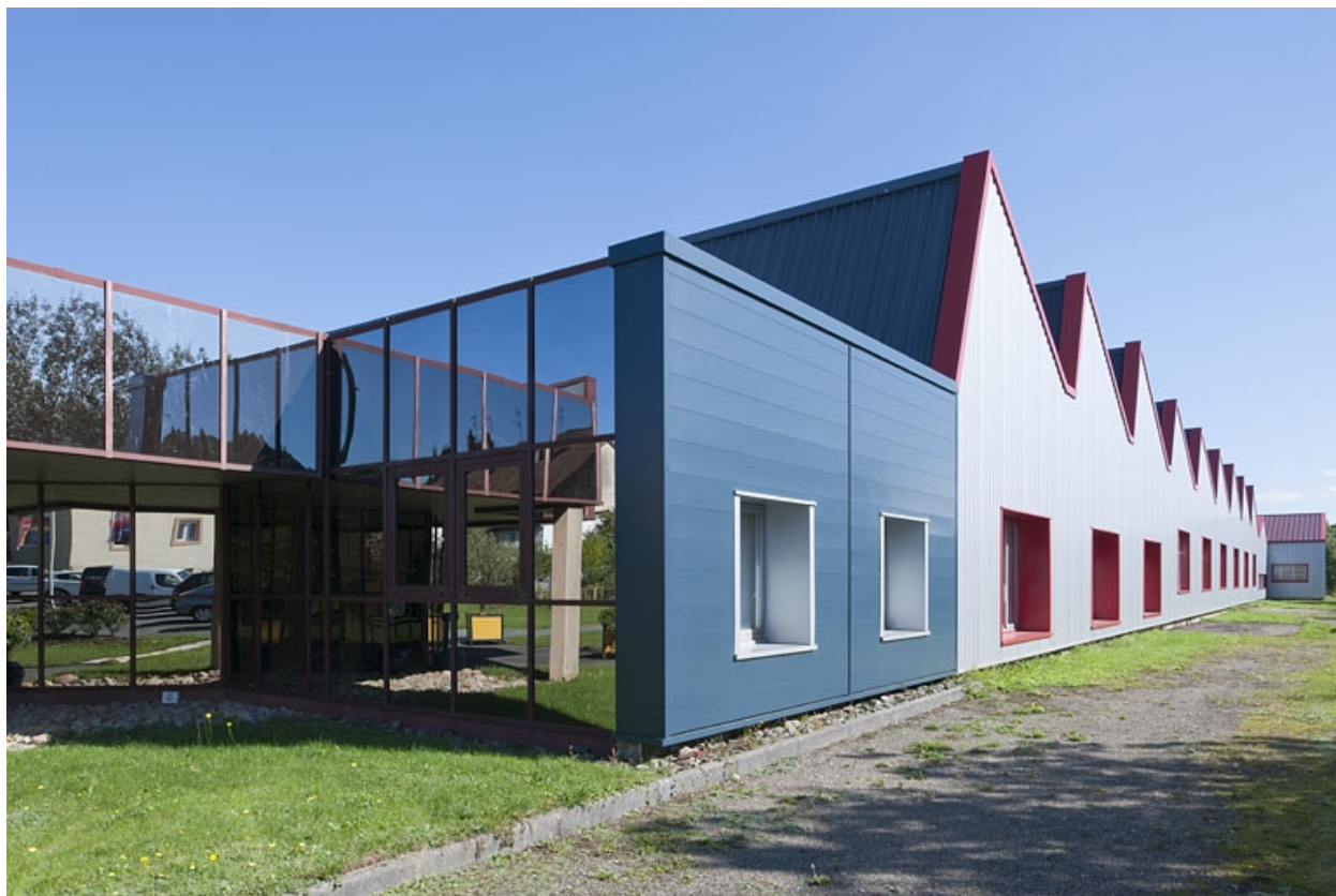
Façade sud de l'atelier de fabrication.
