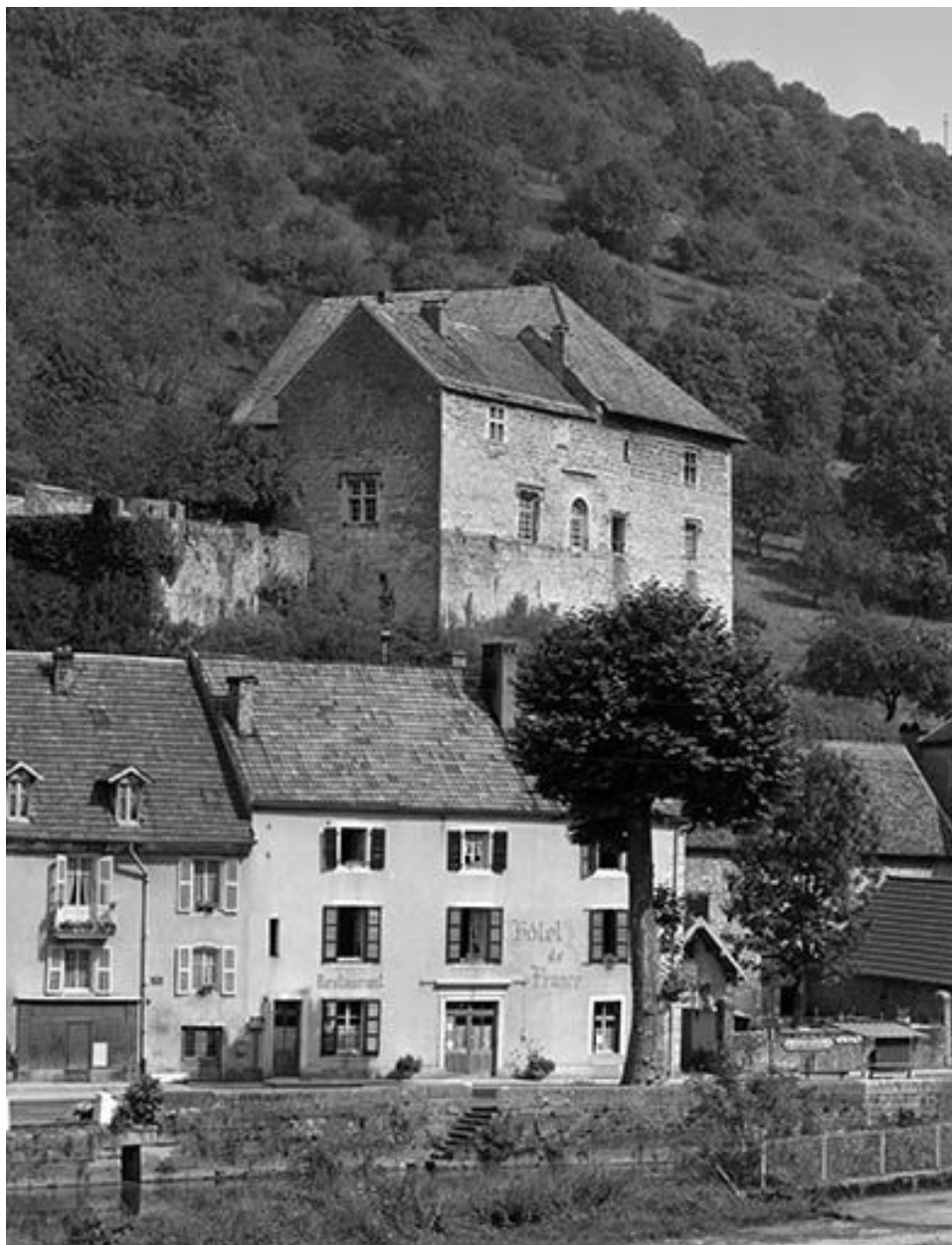
Vue générale, angle sud-ouest.
