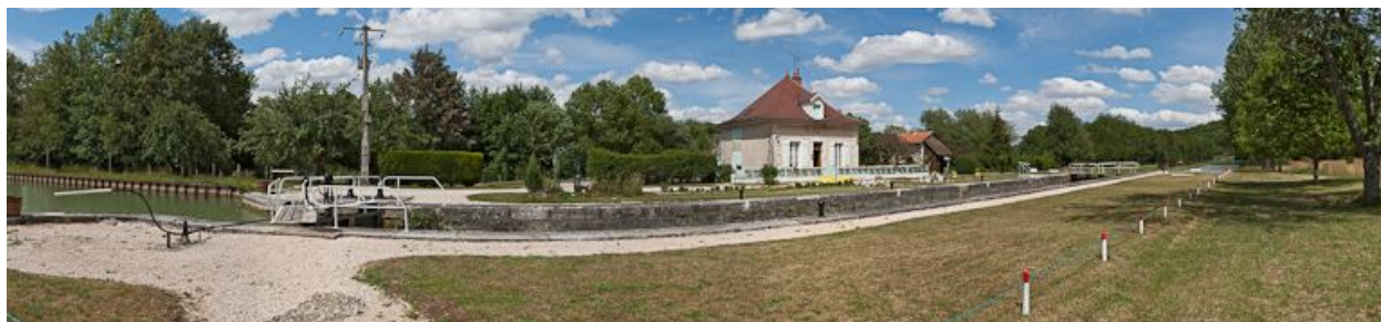
Vue d'ensemble du site d'écluse.
