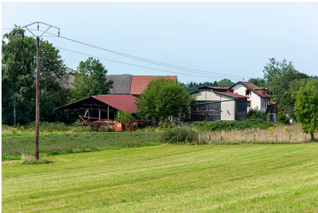
Vue d'ensemble du site, depuis le nord-est.
