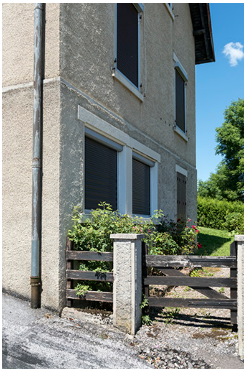
Baies d'atelier à l'étage de soubassement.
