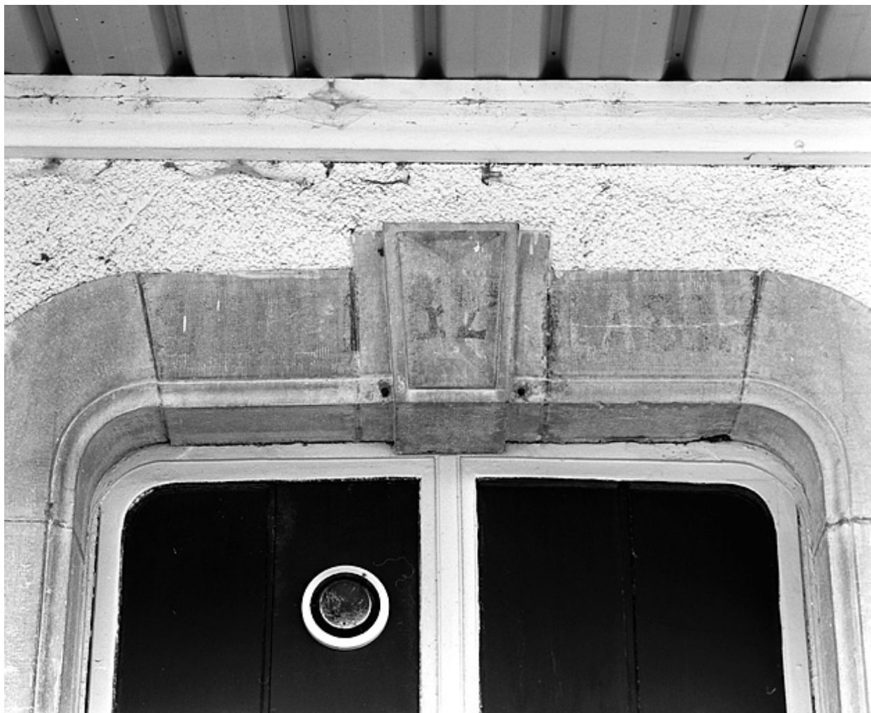
Bâtiment des voyageurs : plate-bande d'une fenêtre.
