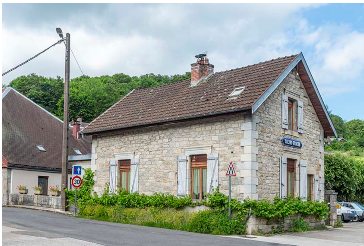
Vue depuis le sud-est.
