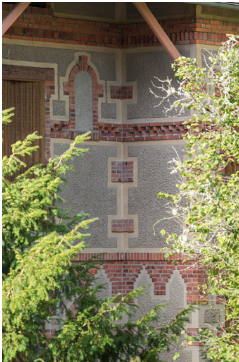
Façade principale, ressaut et décor de brique.
