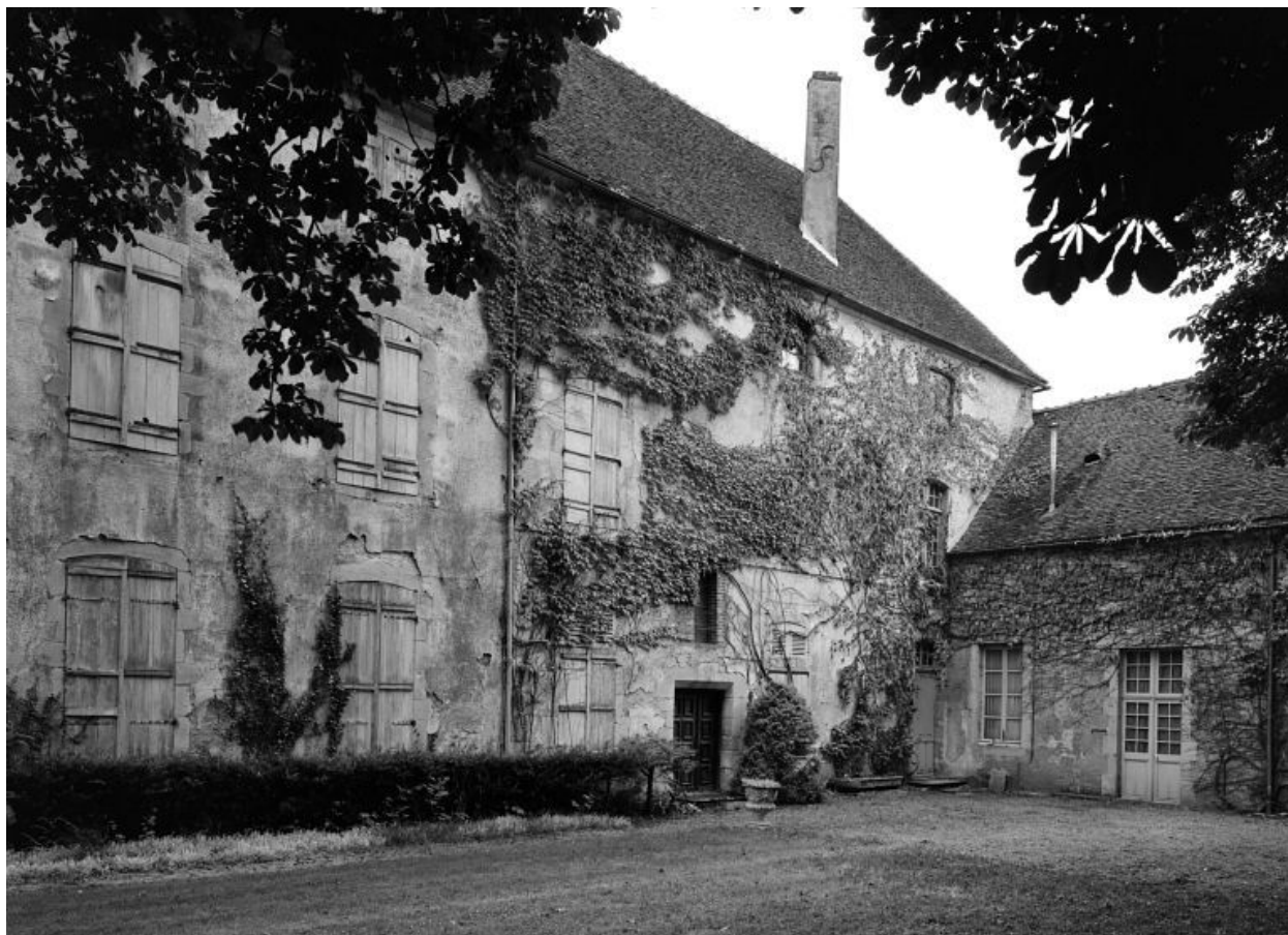
Bâtiment est. Façade prise du nord-est.
