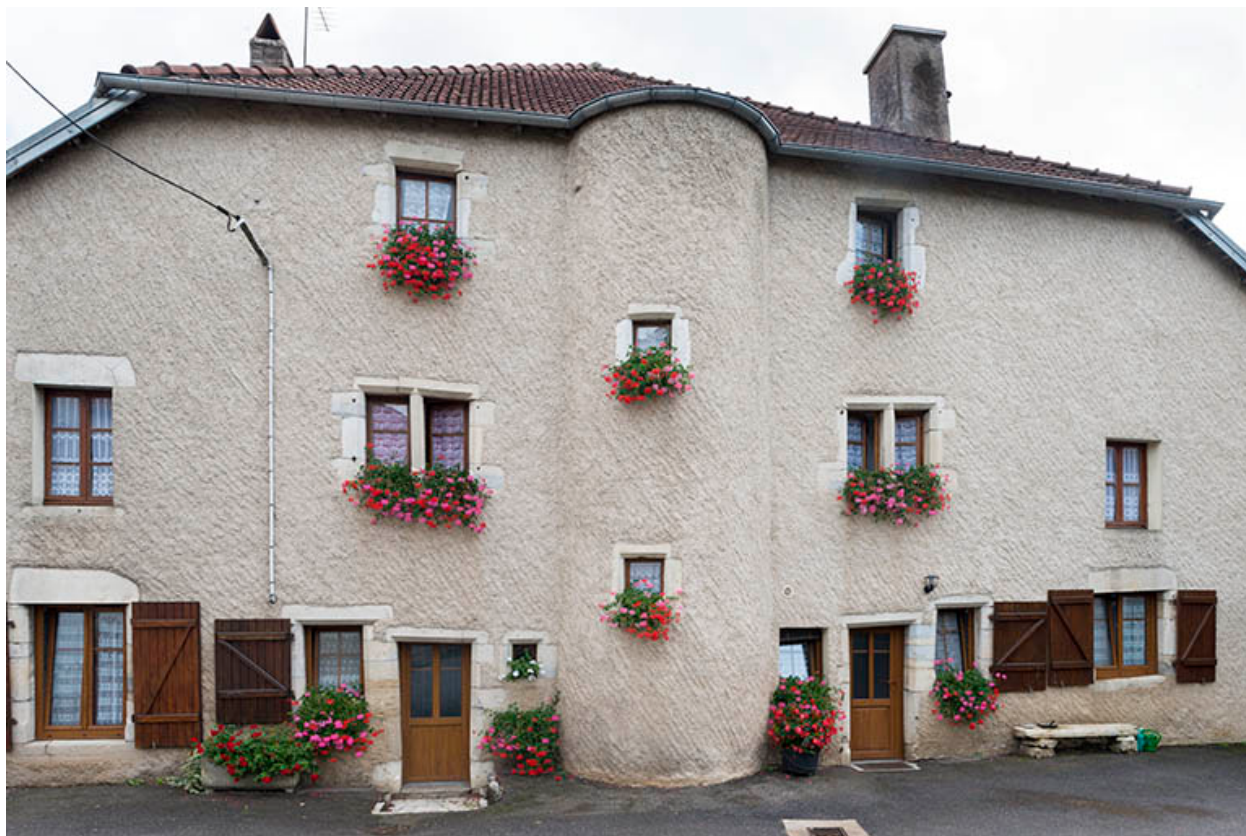
Vue générale de la façade antérieure.
