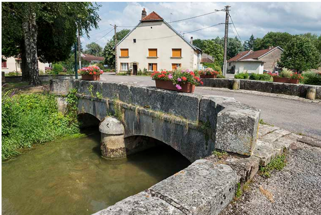
Face nord, vue depuis l'ouest.
