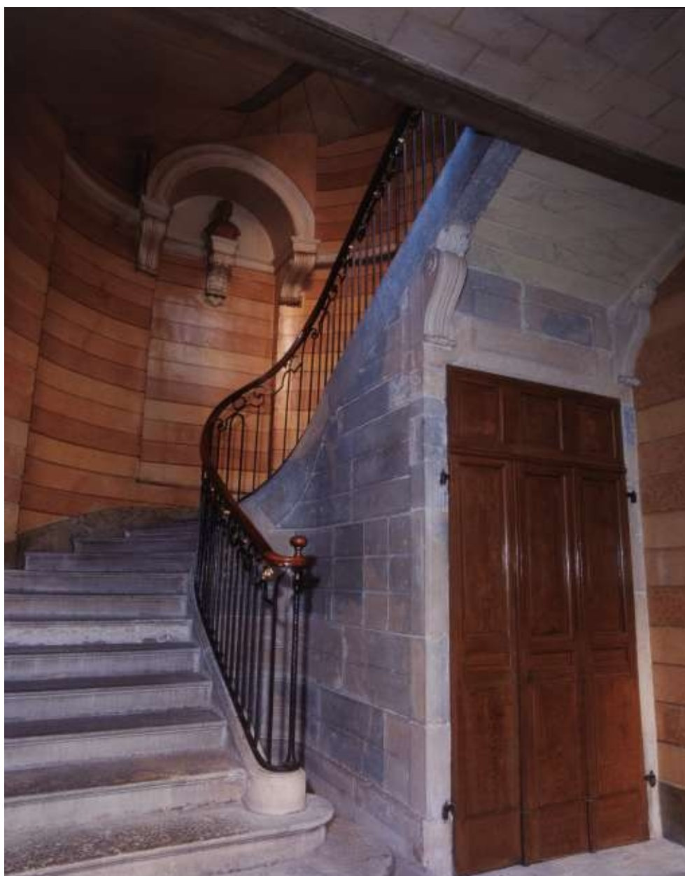
Vue du départ de l'escalier d'honneur.
