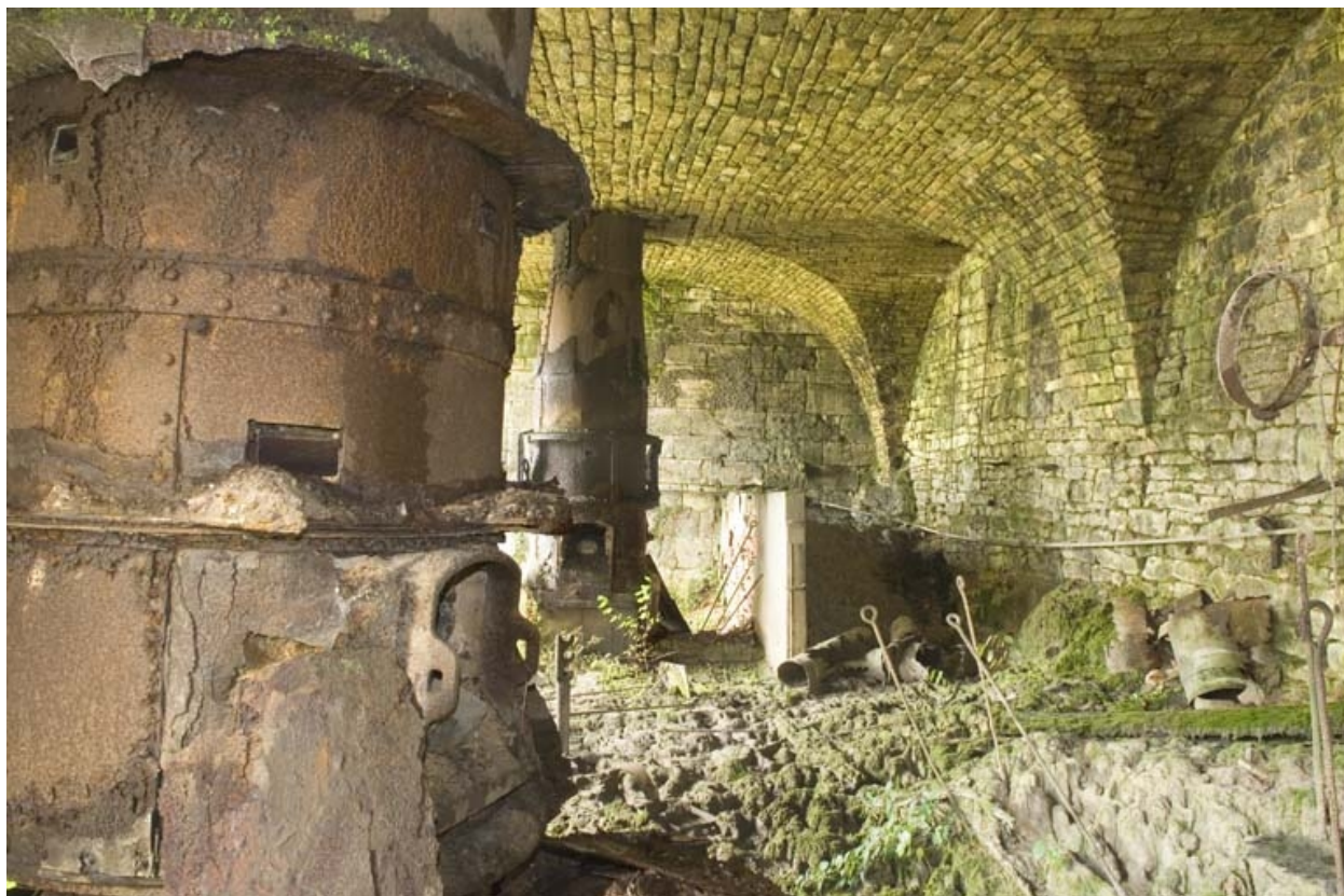
Salle des cubilots. Vue d'ensemble depuis l'ouest.
