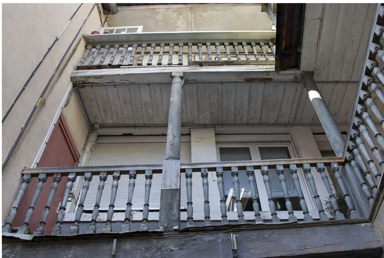
Escalier extérieur : détail des coursières, de face.
