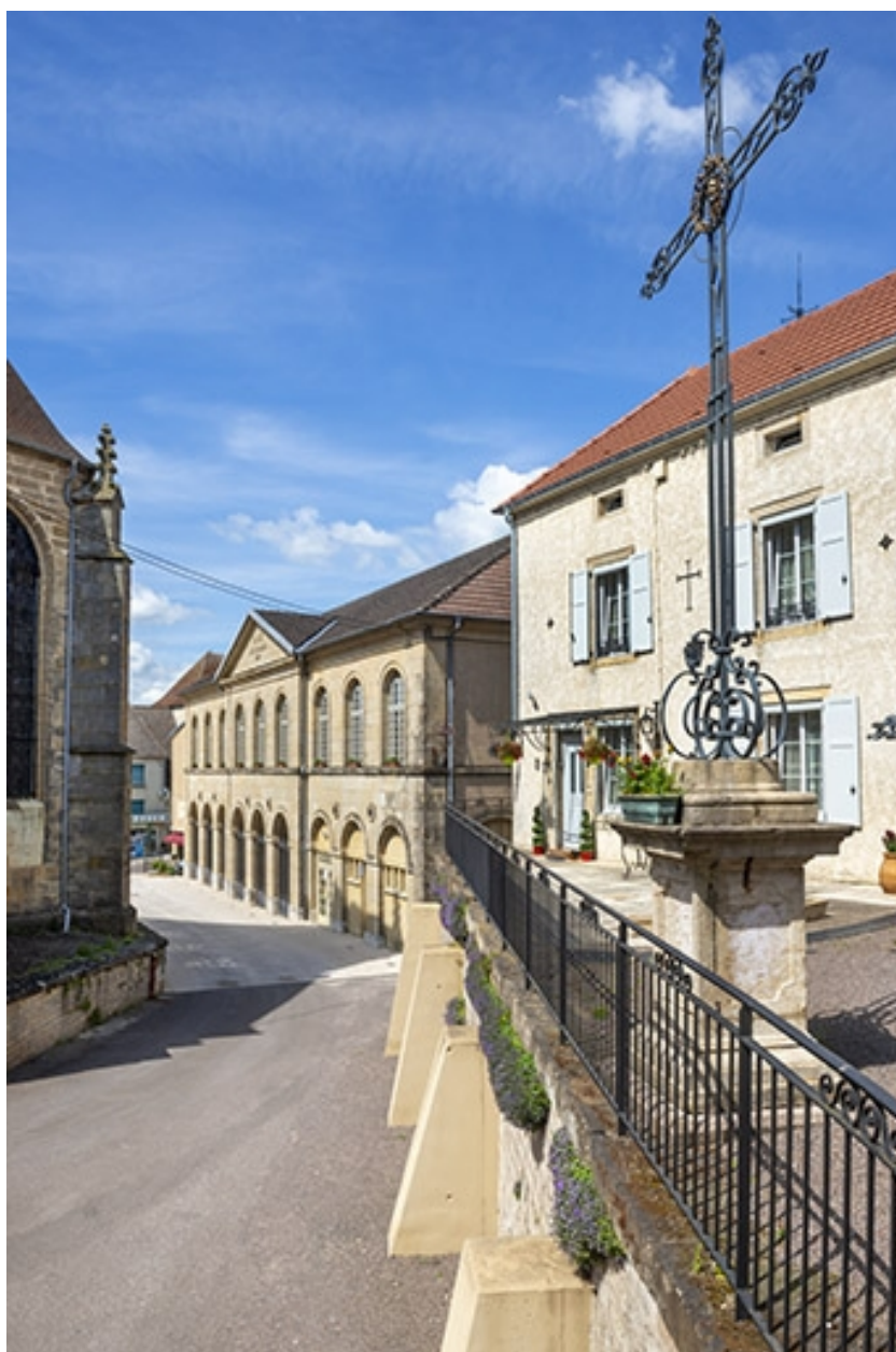
Vue éloignée depuis le sud.
