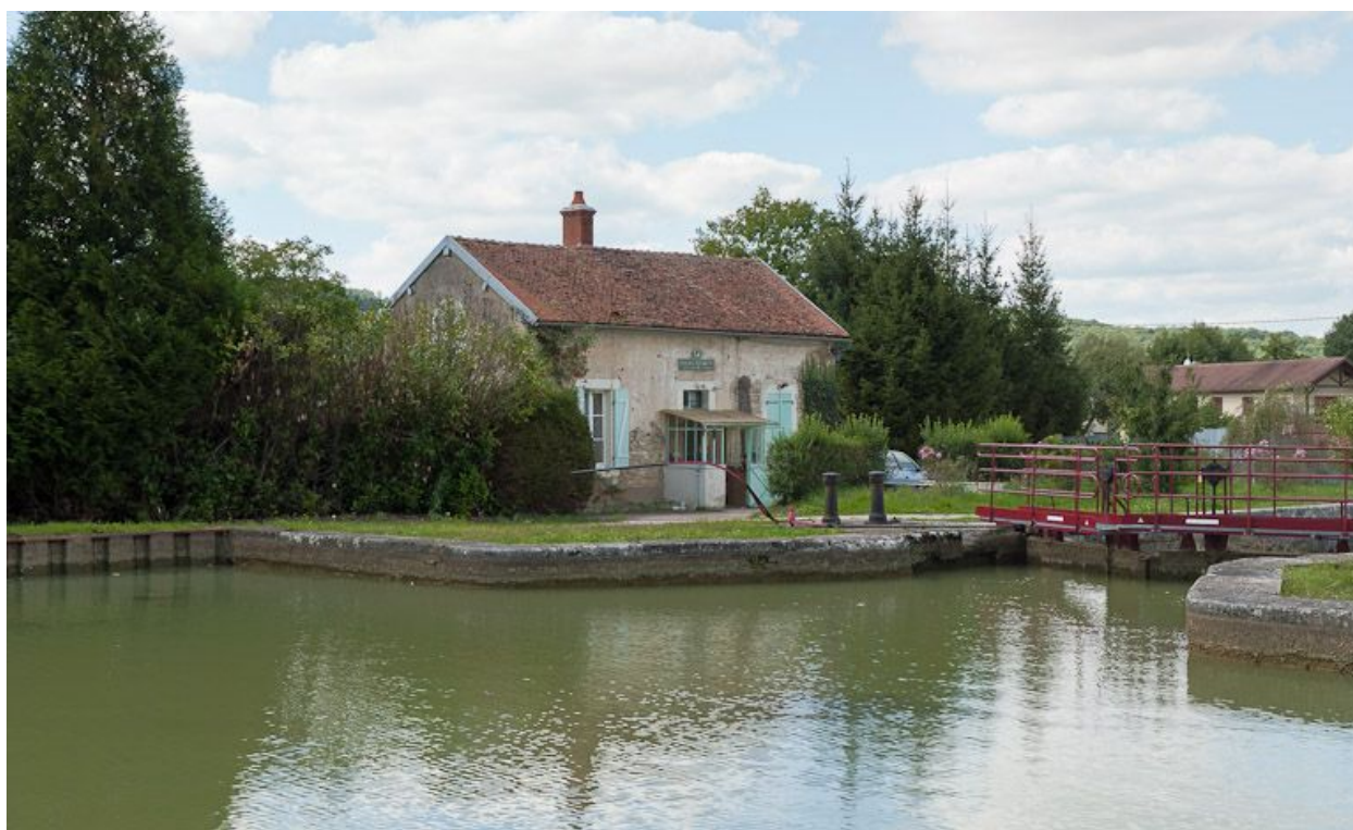
Vue du site d'écluse depuis l'amont.
