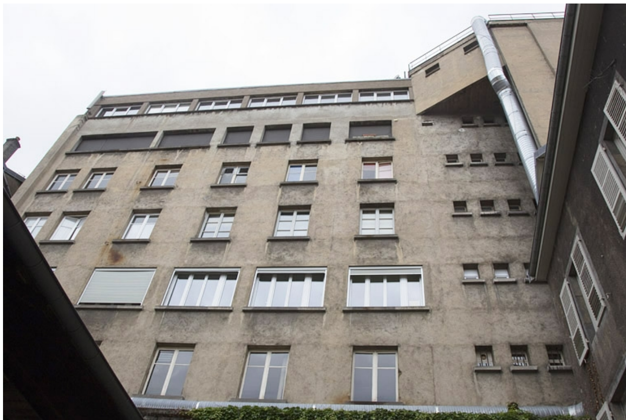
Façade postérieure : vue rapprochée.
