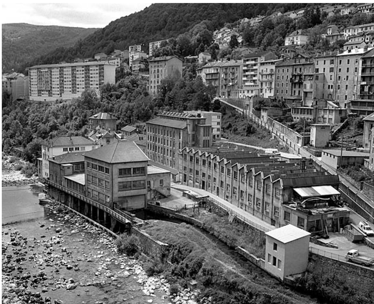
Vue d'ensemble du site depuis le nord-est.
