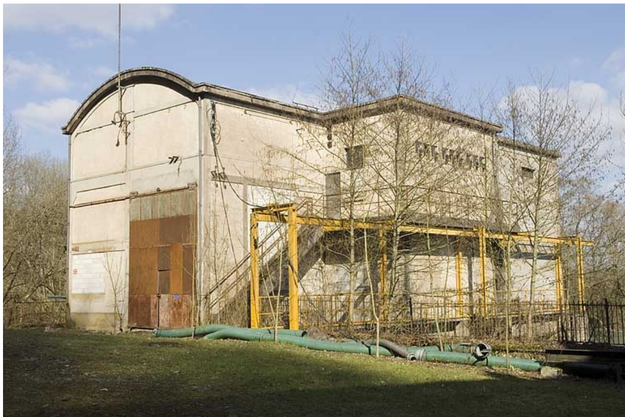
La centrale hydroélectrique vue de trois quarts.
