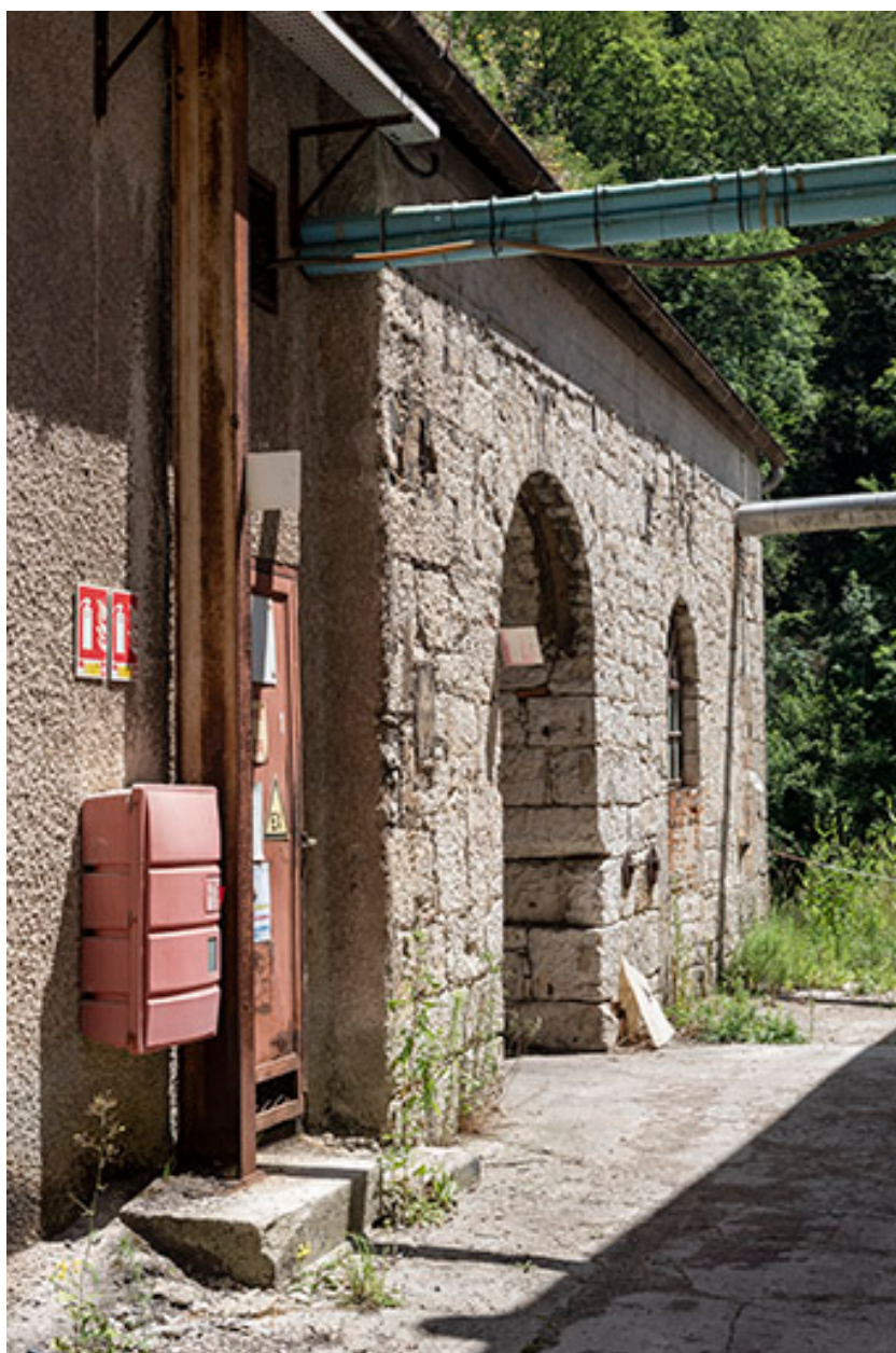
Bâtiment d'eau : façade antérieure, vue en enfilade.
