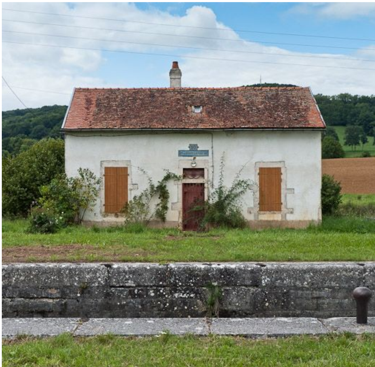
Vue de face de la maison éclusière.
