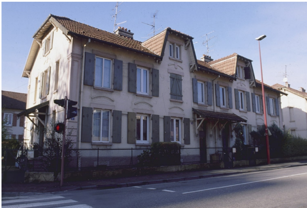
Façade antérieure d'un logement ouvrier rue Voltaire.
