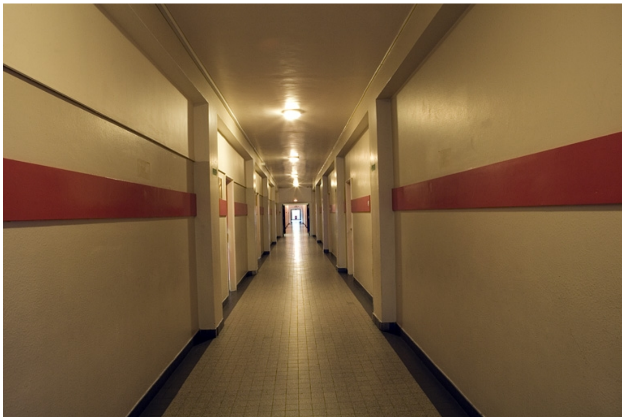
Bâtiment A. Vue couloir.
