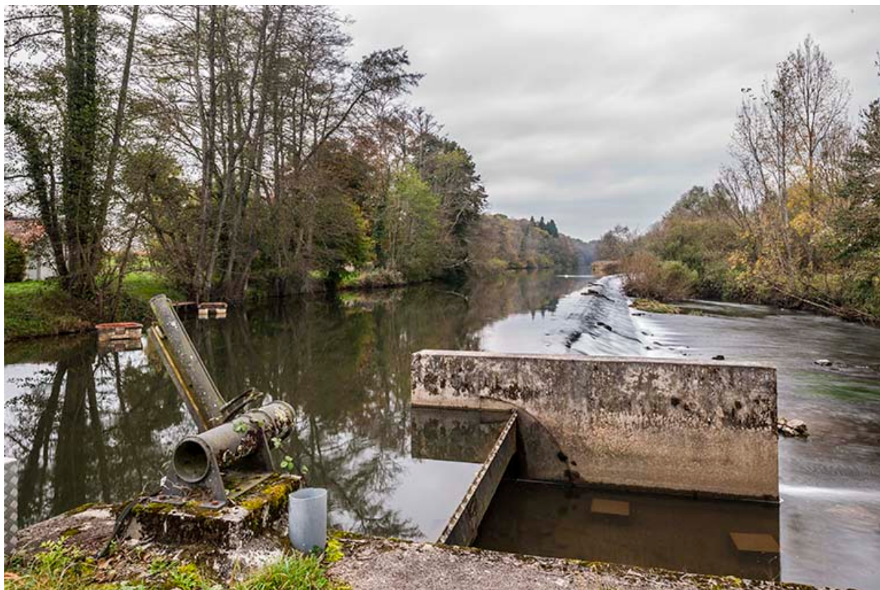
Le barrage sur l'Ognon.
