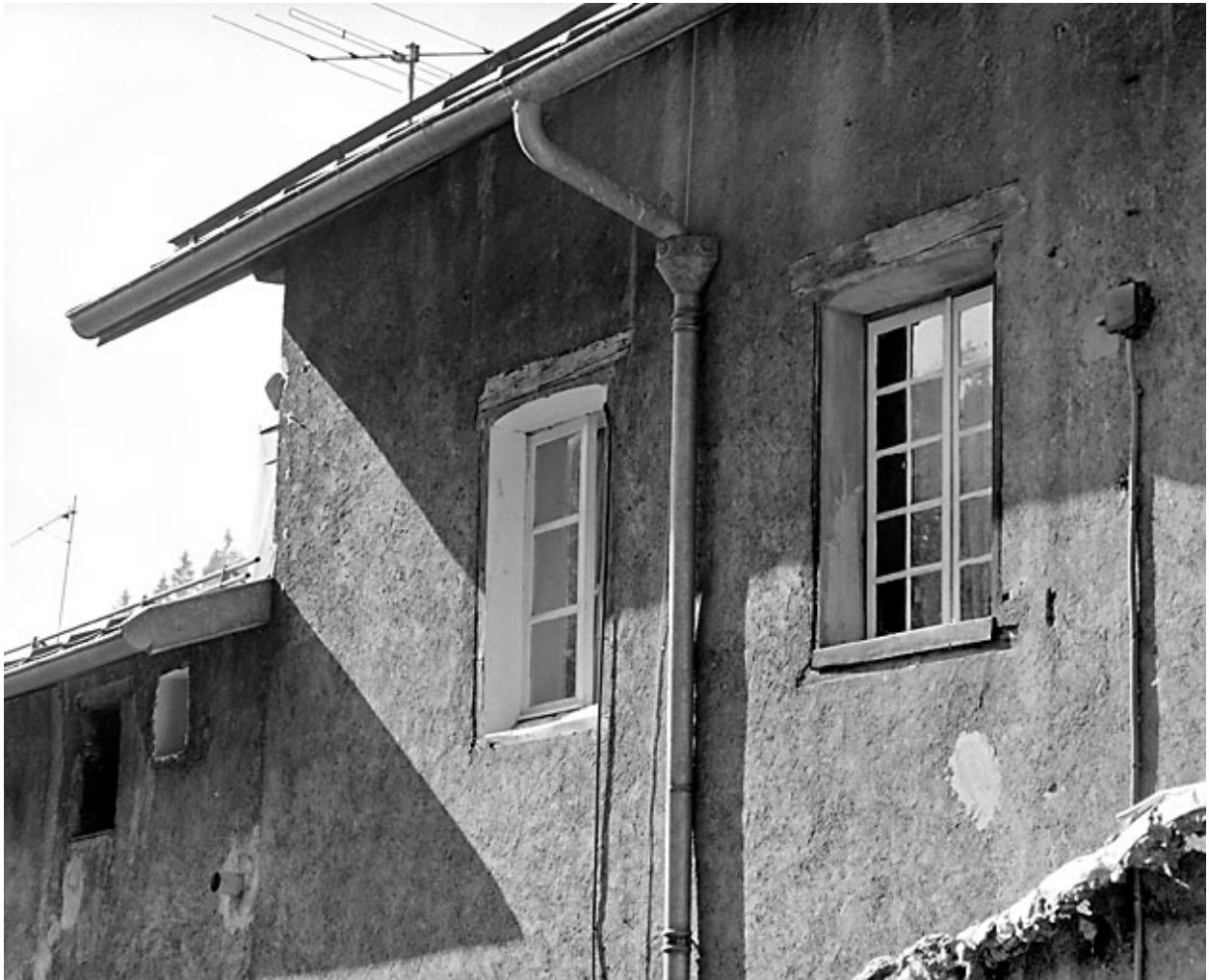
Façade postérieure : fenêtre du deuxième étage, à linteau en bois délardé en arc segmentaire.
