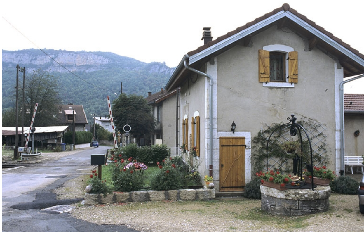
Passage à niveau et façade ouest.
