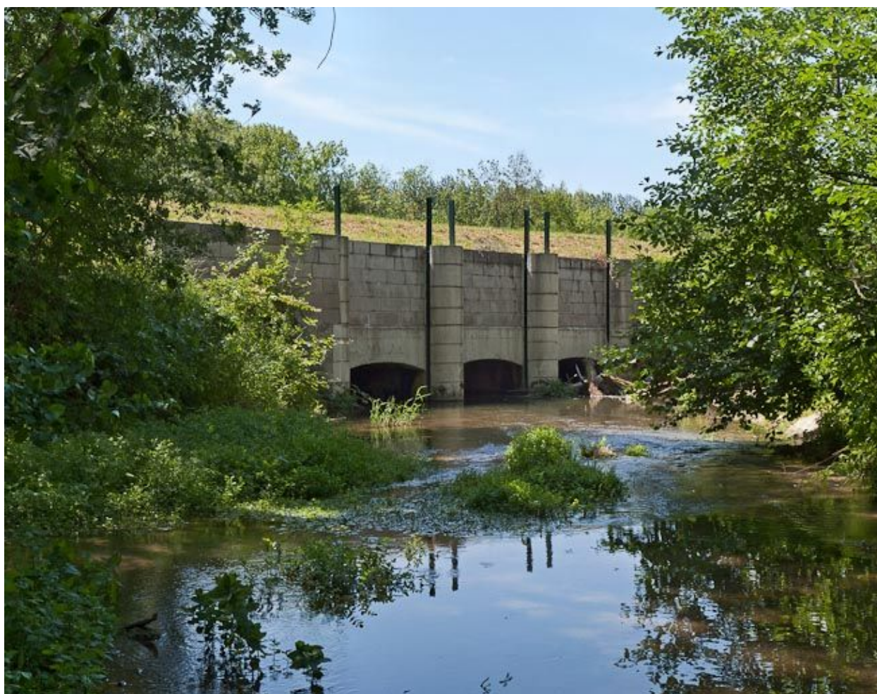
Vue de l'aqueduc.
