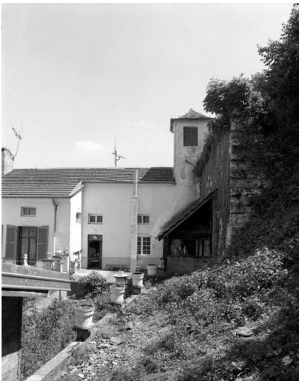
Détail : extrémité de l'aile sur cour.
