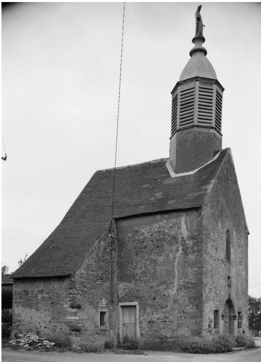
Vue d'ensemble de 3/4 gauche.
